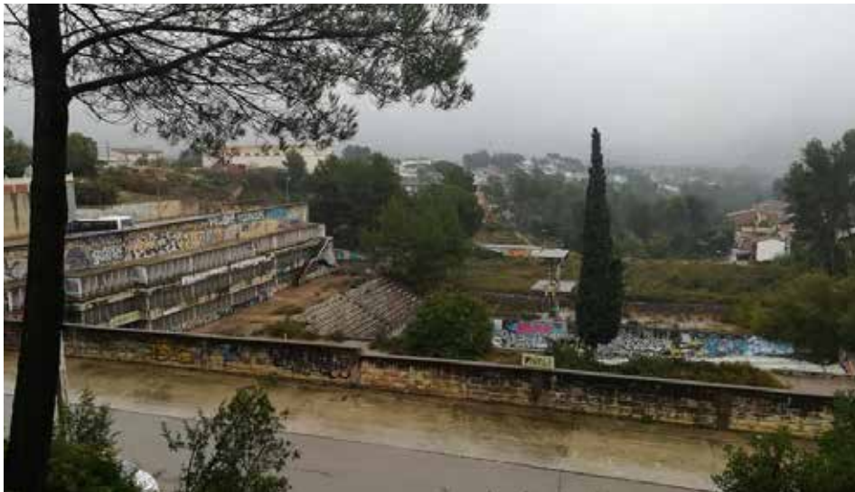
les piscines Castellnou (Rubí)
